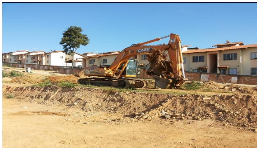
Figura 2: Retirada de raiz de árvore com uma retroescavadeira. Fonte: Arquivo pessoal.
