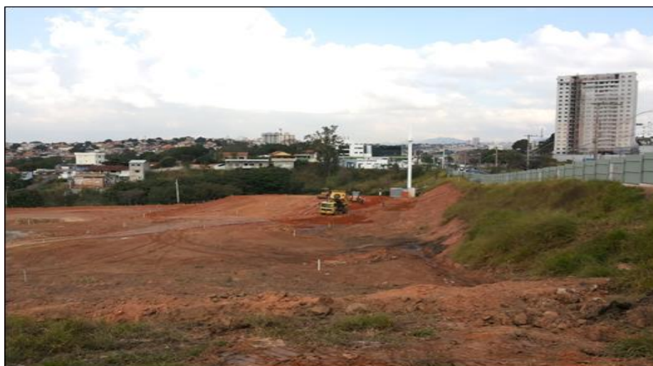
Figura 3: Procedimento de compactação de aterro. Fonte: Arquivo pessoal.
