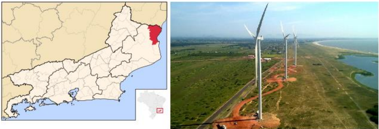
Figura 6. Parque eólico de Gargaú no Estado do Rio de Janeiro.
