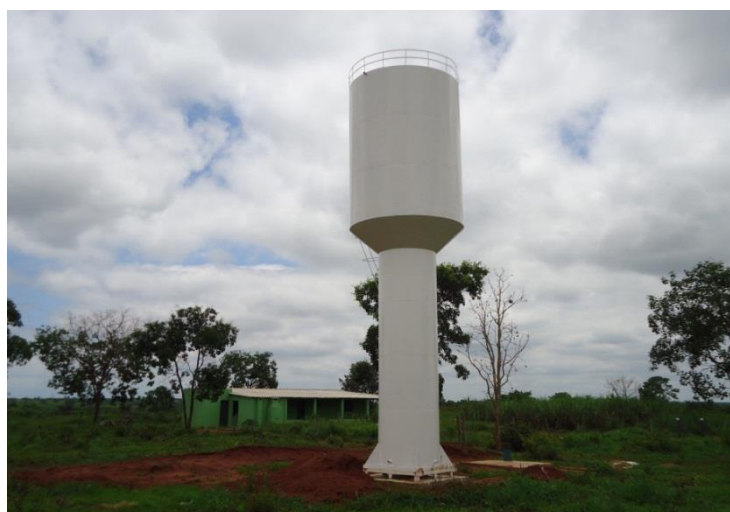
Figura 2: Perfuração do poço e instalação de reservatório de 30 mil litros. Assentamento 20 de Março, Três Lagoas/MS
