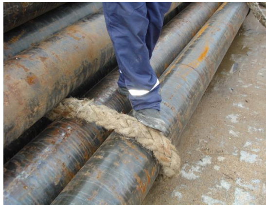
Figura 4: Forma que o Colaborador Pisou no Cabo Trançado de Poliéster Fonte: Empresa KXB-RJ
