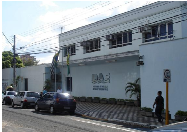
Figura 4 - Fachada do Departamento de Água e Esgoto de Bauru Fonte: DAE Bauru
