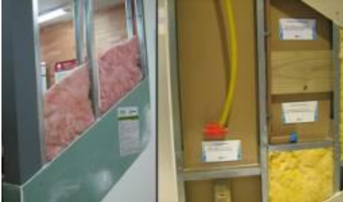
Figura 2 - Parede de “Drywall”. Fonte própria - Foto dos autores na exposição – FEICON (2009).
