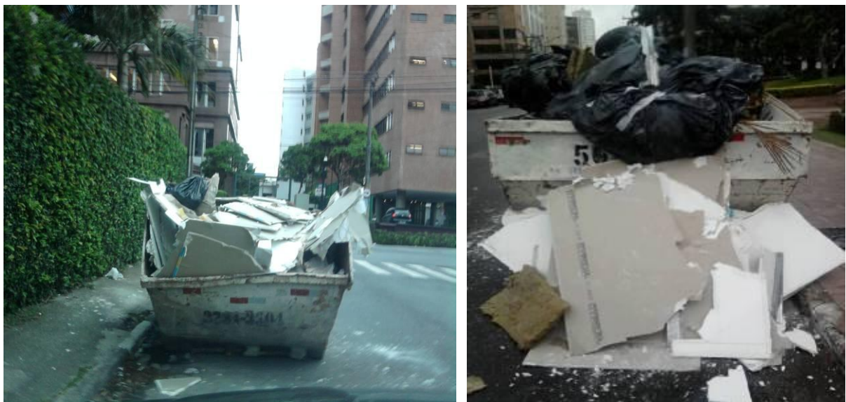
Figura 1 – Descarte incorreto de gesso acartonado (Drywall), em caçambas da cidade de São Paulo, após / durante pequena reforma em prédio de escritórios. Fonte: Foto tirada pelos autores da pesquisa em rua da zona sul da cidade de São Paulo – Brasil (2010).
