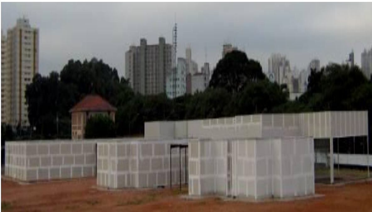
Figura 3 - Grande “Stand” de vendas construído com gesso acartonado – “Drywall”. Fonte: Foto dos autores em ruas da cidade de São Paulo (2009).
