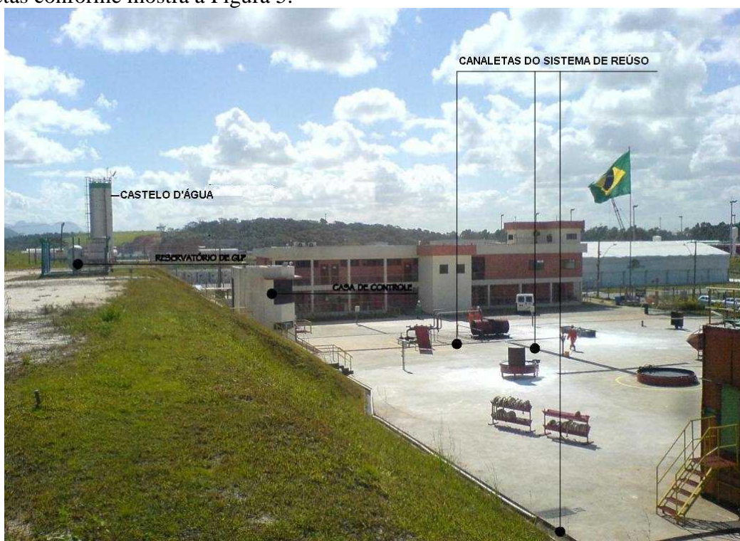
Figura 5 – Visão do centro de treinamento com destaque para o castelo d'água e as canaletas para recolhimento de água; fonte: Sampling Planejamento
