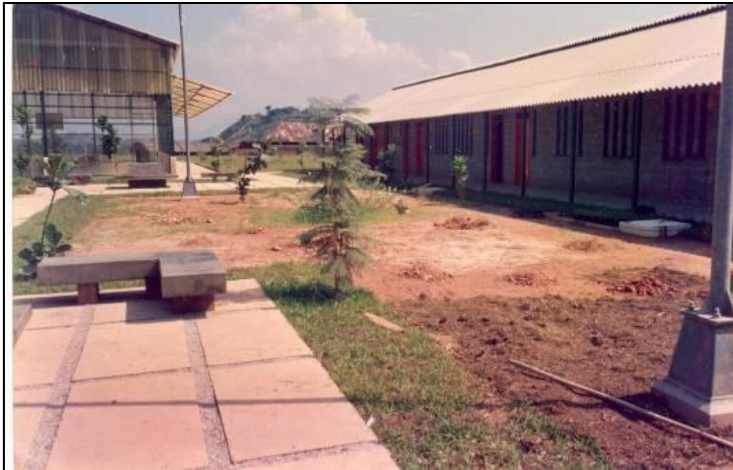
Figura 5.3. Centro Comunitário de Santa Tereza em construção.
