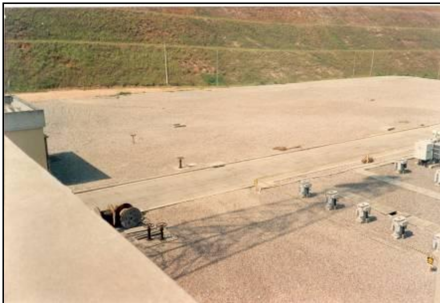
Figura 5.2. Área britada da Subestação na época da inauguração.
